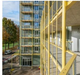
ensemble ist Minergie-P-Eco-zertifiziert. Beim robusten Betonbau setzt die NPG auf Low-tech-Lösungen; so wurde beispielsweise eine einfache Nachstromlüftung installiert, und die Storen sind mit Handkurbeln ausgestattet. Die Metallkonstruktion der Laubengänge wurde
